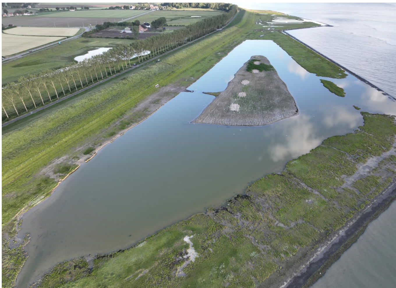
Het eiland in het Voorland van Nummer Eén, 11 juni 2024 (foto Maarten Sluiter)
