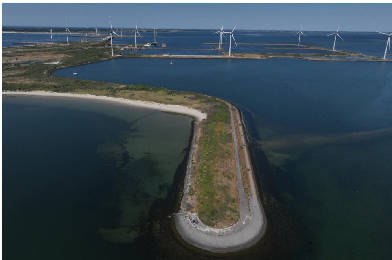
De noordelijke pier van de Mattenhaven, 14 juni 2023 (foto Maarten Sluijter)
