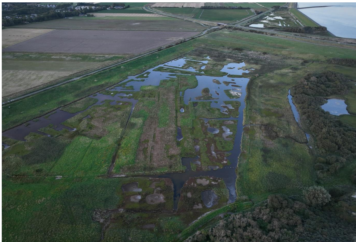
Het westelijk deel van de Westenschouwense Inlaag, 23 augustus 2023 (foto Maarten Sluijter)
