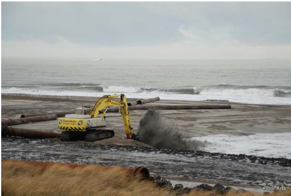
Foto 1. Het aanbrengen van zand voor de Westkapelse Zeedijk.
