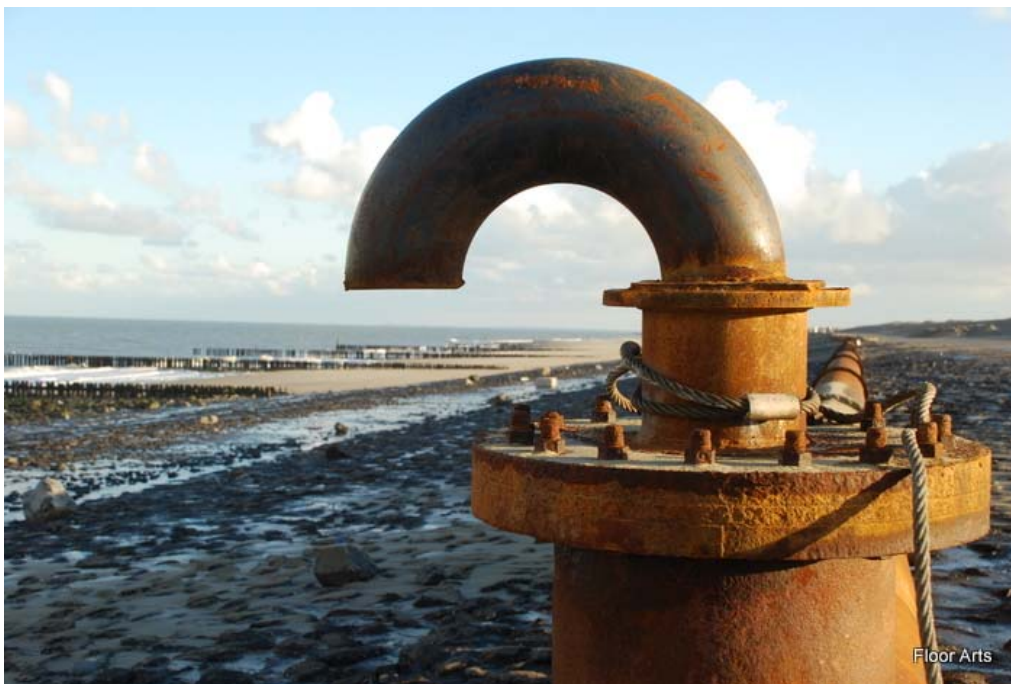
Foto 6. Westkapelse Zeedijk tijdens de werkzaamheden.
