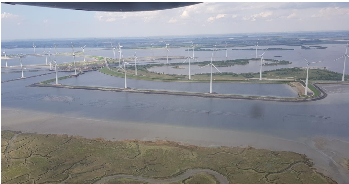
De Krammersluizen, gezien vanuit het zuiden, 26 april 2019 (foto Maarten Sluijter)
